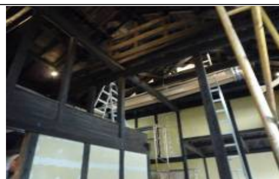
津波を免れた陸前高田市気仙町の古民家の部材が取り入れられている。
