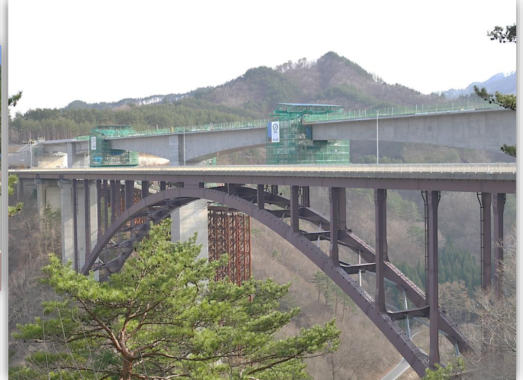
新思惟大橋の建設
