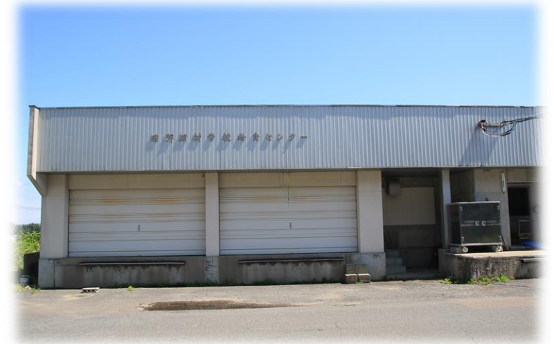
旧学校給食センター R2.7.31閉所 (S54年～)
