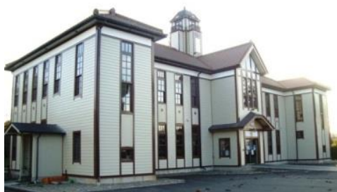
旧緯度観測所本館 (奥州宇宙遊学館) H29. 10. 17 国登録有形文化財 登録
